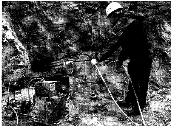
(a) 가압펌프를 이용한 그라우트액 주입
