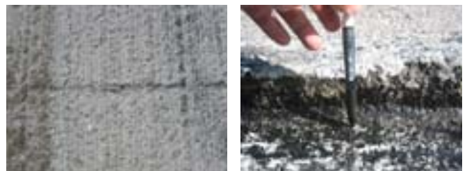
(c) 콘크리트 포장 절삭면
