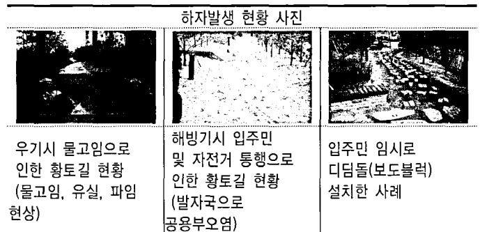
그림 2. 산책로 포장 마감재 하자 발생 현황
