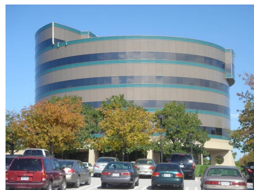
그림 1. 적용 대상 건물 전경
