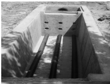
(d) perforated pipe installation
