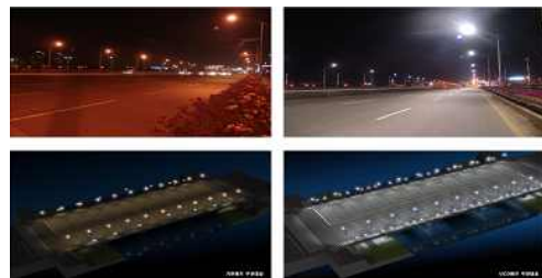
<그림 15> 나트륨 250W 대비 UCD120W 설치사진 (설치 전 시뮬레이션 전주시 추천대교)
