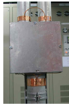
(a) Equipotential bonding
