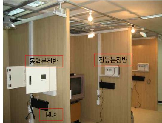
그림 12. 재래시장 Test-Bed 및 상가 분전반 구성
