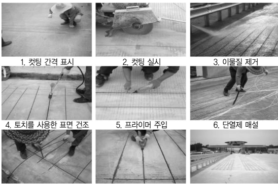
(그림 2) 용설 시스템 시공 공정
