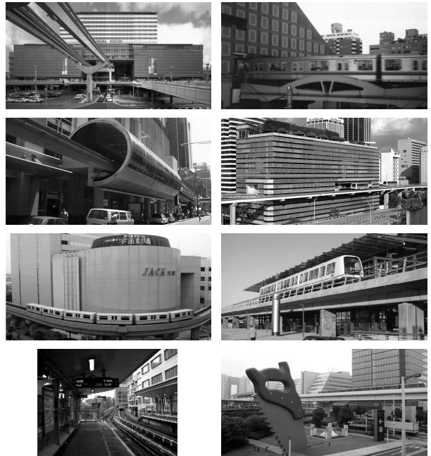
그림 1. 가볍고 급곡선 및 급구배 주행성이 우수하여 건물로 직접 진입하고 있는 경량전철의 예
