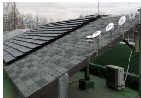
그림 5. 2kW급 계통연계형 PV시스템
