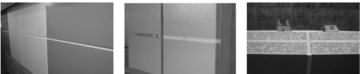
[그림 3] 건식 외단열 시스템
