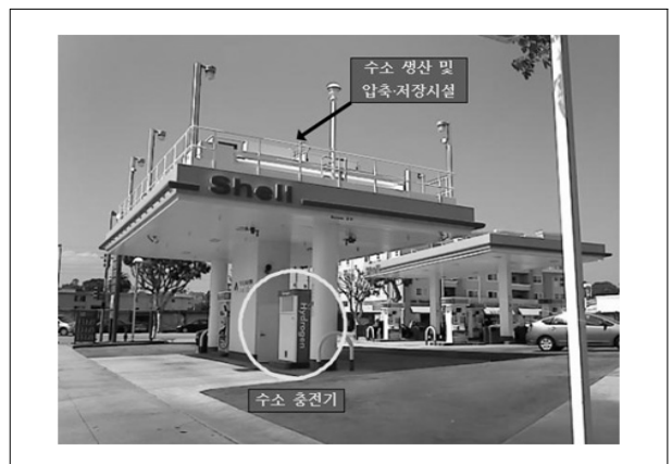
Fig. 6 기존 가솔린 충전소와 병설 설치된 수소충전소(미국, LA)
