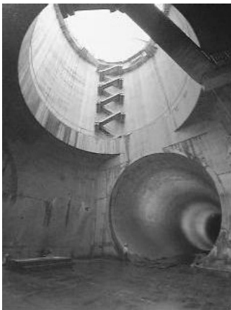
사진 6. 지하조절지 터널 입구
