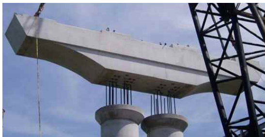
사진 1. Lake Belton Bridge
