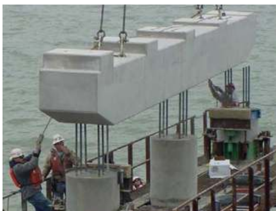
사진 2. Lake Ray Hubbard Bridge
