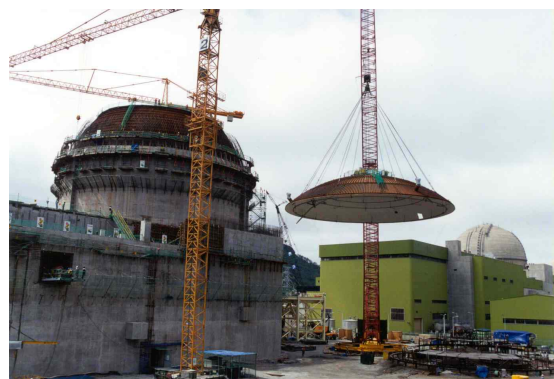
사진 1. 원전 구조물 시공전경
