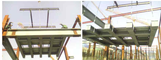
사진 1. 모듈부재 양중 사진
