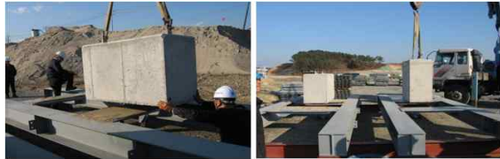
사진 2. 바닥 판 슬래브 처짐 개선을 위한 Mock-up
