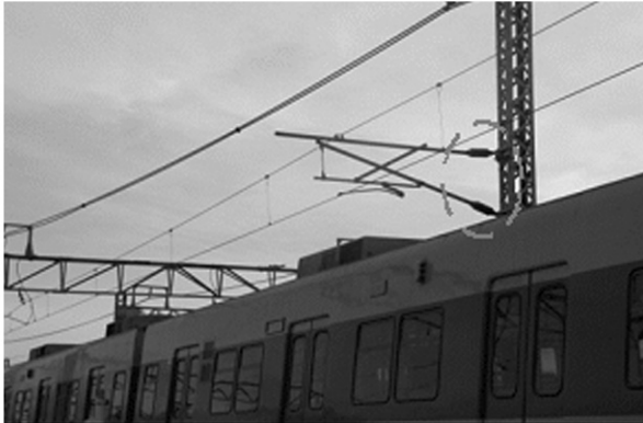
그림 11. FRP 장간 애자 설치 전경
