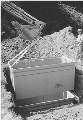
그림 8. FRP 집수정 시공
