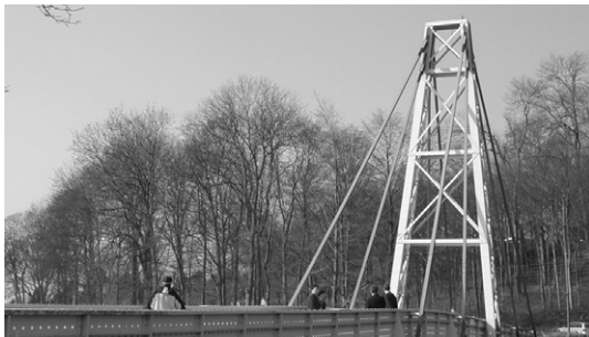
그림 9. 전체 FRP 교량, Bolt 연결(Kolding)
