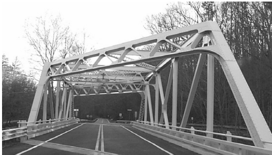
그림 11. 바닥판 FRP 교체 도로교(Maryland)
