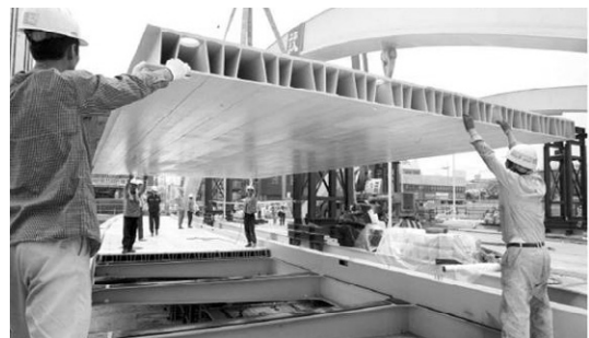
그림 12. 청계천 인도교 바닥판 시공
