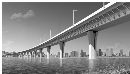
그림 14. 인천대교 FRP Strut설치구간
