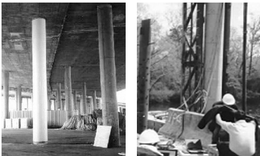
그림 17. 기둥 및 파일 시공
