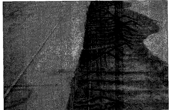
그림 4. TSQ-1 댐의 차수벽에 발생한 콘크리트 박락과 철근의 휨 변형
