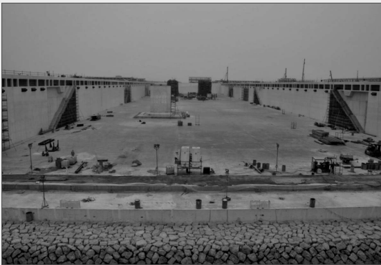
〈그림 17〉 Dry Dock 시공 전경
