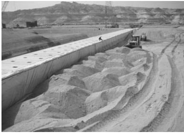
〈그림 16〉 육상 부분 안벽 시공 사진
