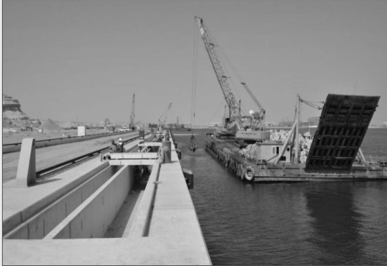
〈그림 18〉 안벽 시공 전경
