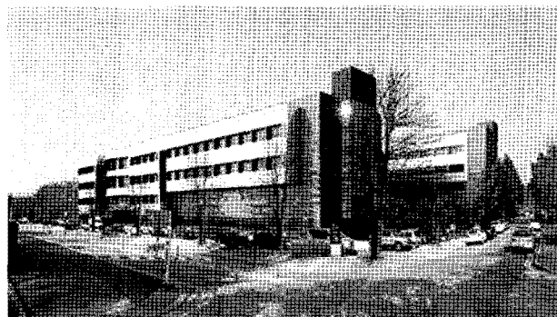
약학·이학관 리모델링 전·후 전경
