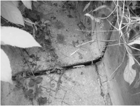
그림 16. 시공불량으로 배수기능 저하
