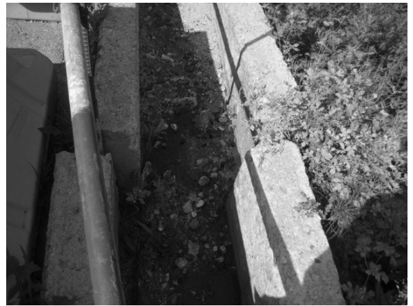
그림 19. 설계용량 과소설계로 인한 월류
