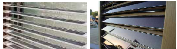
그림 2. 차양시설 접용형 BIPV 시스템 Fig. 2. BIPV system with blind system
