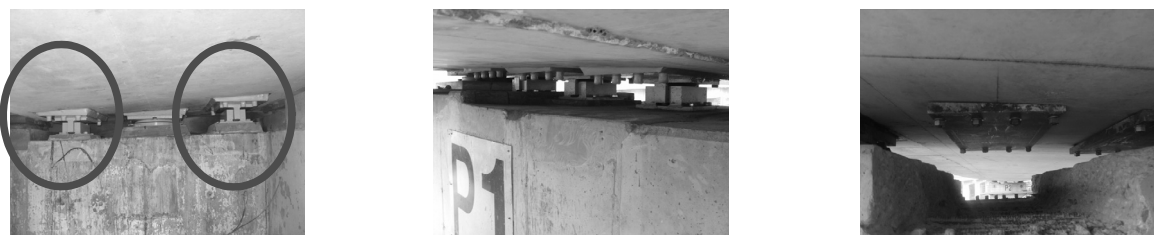
〈그림 2〉 받침보호장치 설치 예
