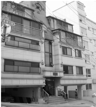
〈그림 5〉 서울에 위치한 5층 콘크리트 구조물
