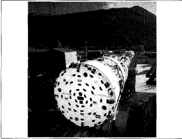
그림 3. 대구경 Traffic TBM 발진 준비
