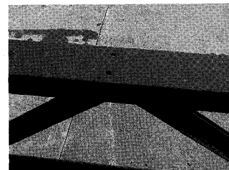
그림 16 Secondary 접합용 Hole
