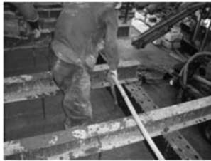
(f) 콘크리트 타설
