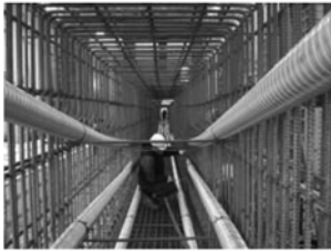
(a) 철근 조립 및 슈스관 설치
