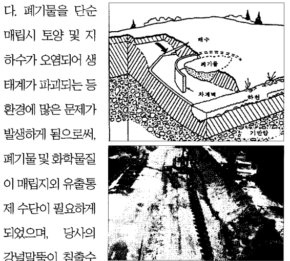
〈그림 6〉 성주군 생활폐기물 처리시설 침출수 방지 설치장면
