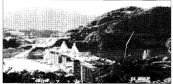
[그림 21] 운암대교 시공 전경
