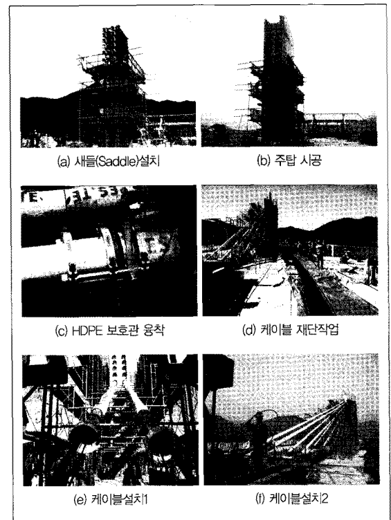
[그림 17] 주탑 및 케이블공 시공과정
