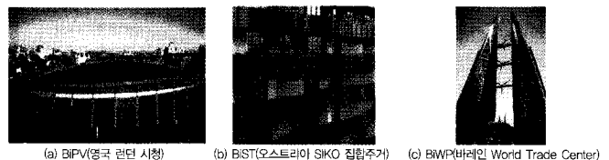
(그림 5) 건물일체형 신재생에너지 적용사례
