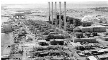
〈그림 3〉 사우디아라비아 알코바 담수화발전소 건설공사 전경
