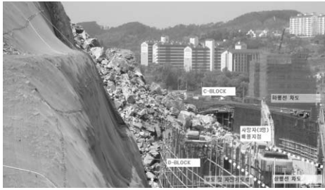
〈그림 1〉 개착식 터널 절취사면 붕괴로 매몰
