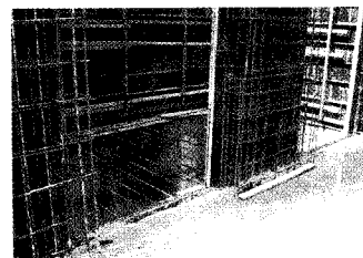
▶ 개선 전 엘리베이터 구간 추락위험
