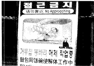
해체구간 접근금지 표지판 설치
