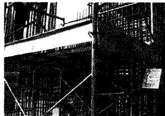
틀비계 가새 설치
