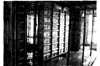
▶ 개선공법 알루미늄 거푸집을 사용한 1단 설치로 벽체 및 천정 설치
