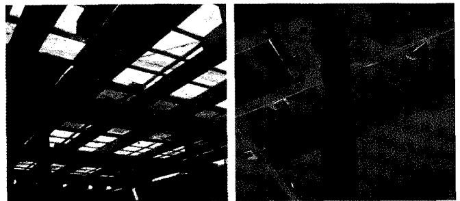
〈그림 3〉 단면이 부족한 명예제 사용, 변형된 동바리 사용
