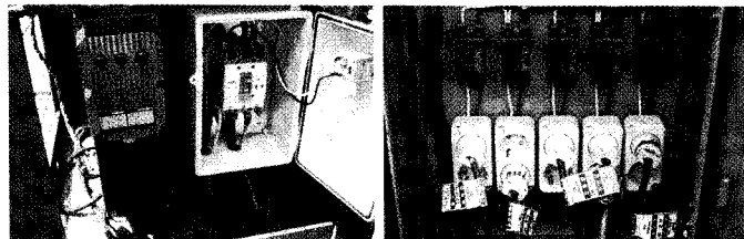
〈사진 5〉 용접기/콘센트 누전차단기 접속상태
