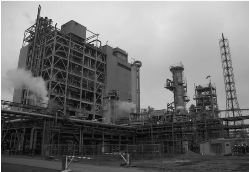
▲ Shell사 건식 석탄공급(Dry Coal Feeding) 방식을 이용한 최초의 IGCC 발전소인 네덜란드 Buggenum IGCC 발전소
