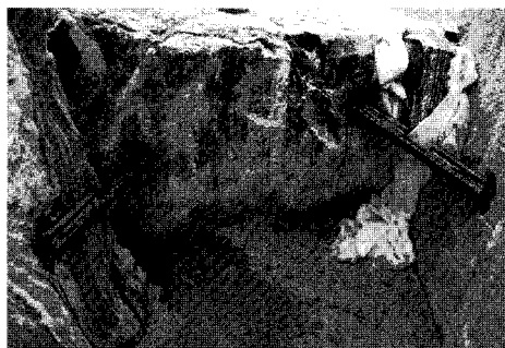
〈그림 1〉 Set Anchor 설치
