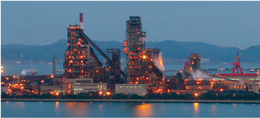
가루 형태의 철광석과 일탄을 직접 사용해 쇳물을 생산하는 친환경 첨단시설인 연산 150만톤 규모의 파이넥스 공장
