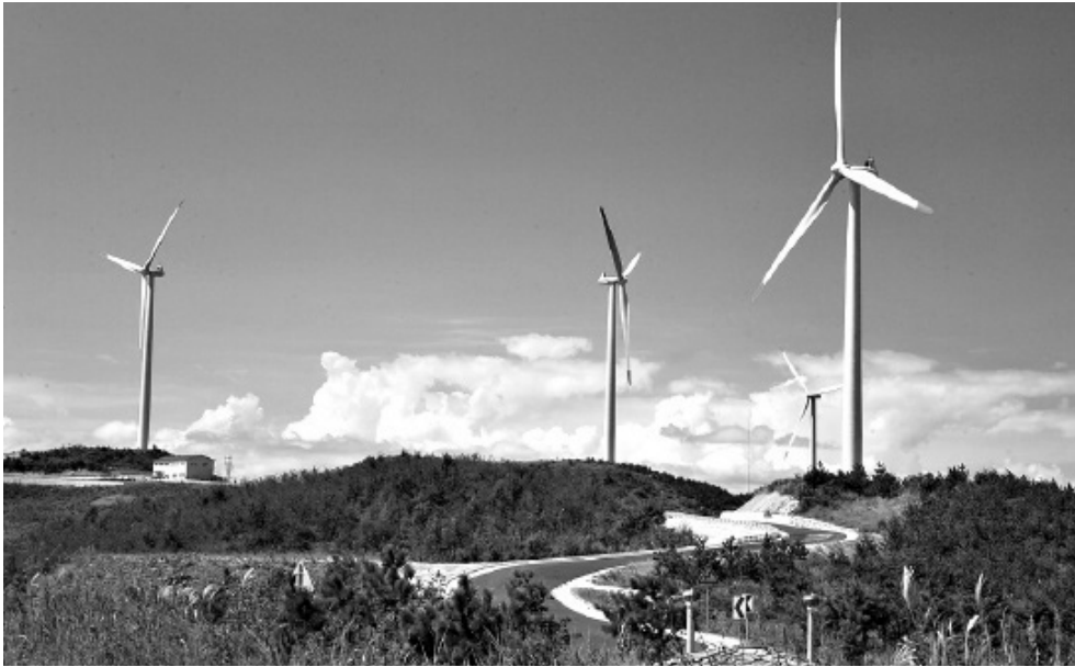
▲ 국내 최초의 민간투자 발전소인 영덕 풍력발전단지 전경
