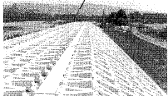
사진 7. 하천 전면 및 배면의 연속거치 전경
