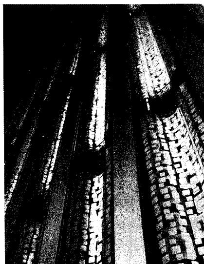
패널의 회전 구동은 자동경첩과 모터 연동의 힌지룰러의 조합시킨 단순한 가동 기구를 신규 개발했다. 정지하고 있는 상태에서도 패널은 부유감이 있어 당장 움직일 것 같은 기운이 갑돌게 된다. 낮시간대에는, 반 투과의 패널은 동남쪽에서의 강한 빛을 부드럽게하는 차양 스크린으로서 유효하게 움직이고, 평상시에는 베네시안블라인드 등으로 빛을 차단하면 시각적인 거리와 차단되어 버리지만 실내에서는 긴자라고 하는 거리를 가까이에 느낄 수 있다. 이중외피과 패널의 조합에 의해서 사람의 피부와 같이 내부 환경을 지켜 에너지 절약 효과도 얻을 수 있다.
