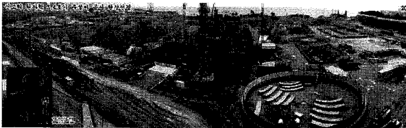
<그림 2> 신고리 3,4호기 공사현장 전경
