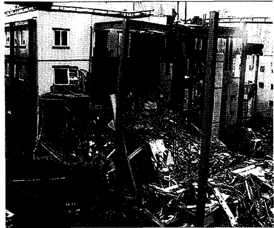
[그림 3] 리모델링 공사중 붕괴사고
