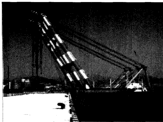
주 : 한진중공업 시공(1991. 6. 23~1995. 7. 31, 공사액 33백만불)
