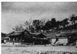
1930년대 말 외부 담장 설치 전
