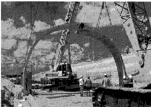
그림 1. 프리캐스트 조립식 터널 시공전경(프랑스)
