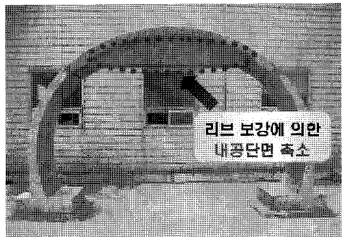
그림 9. 리브 보강에 의한 터널 내공단면 변화
