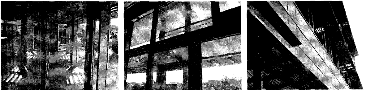
[그림 3] 내부형 이중외피시스템 및 가동형 외부차양
