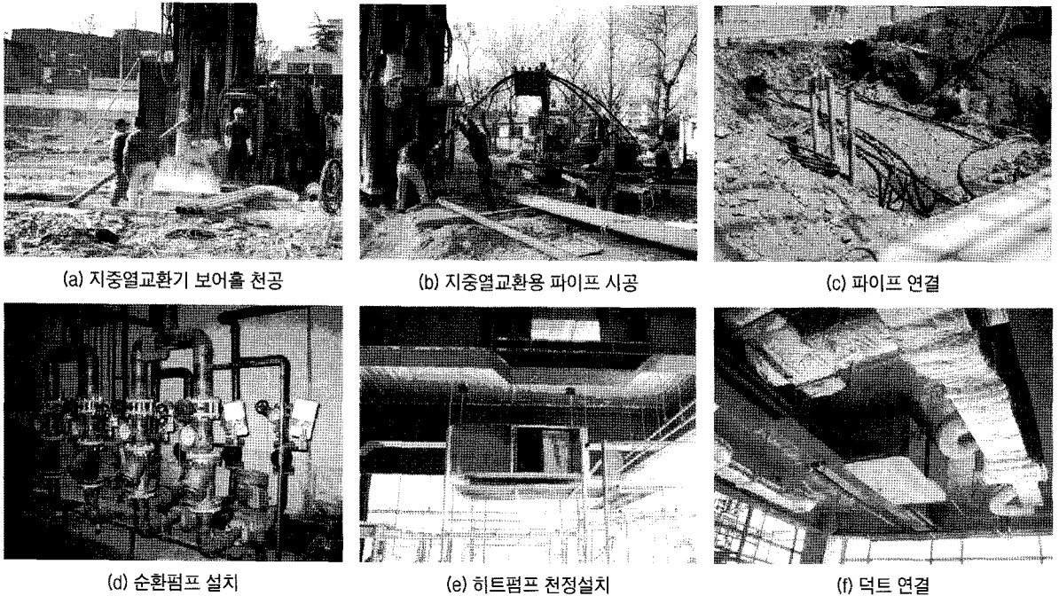
[그림 6] 지열냉난방시스템의 시공과정
