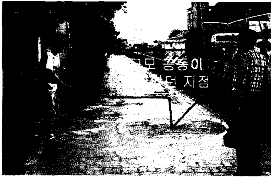
사진 5.1 하수관 역류로 인한 공동 형성
